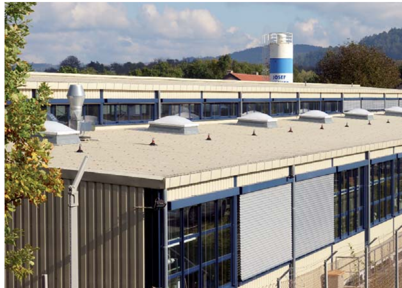
Im Oktober 2009 hat die Energiegemeinschaft Weissacher Tal eG 100 Kilowatt Nennleistung auf dem Dach des Verpackungsmaschinenherstellers Harro Höfliger in der Nachbargemeinde Allmersbach im Tal installiert.
